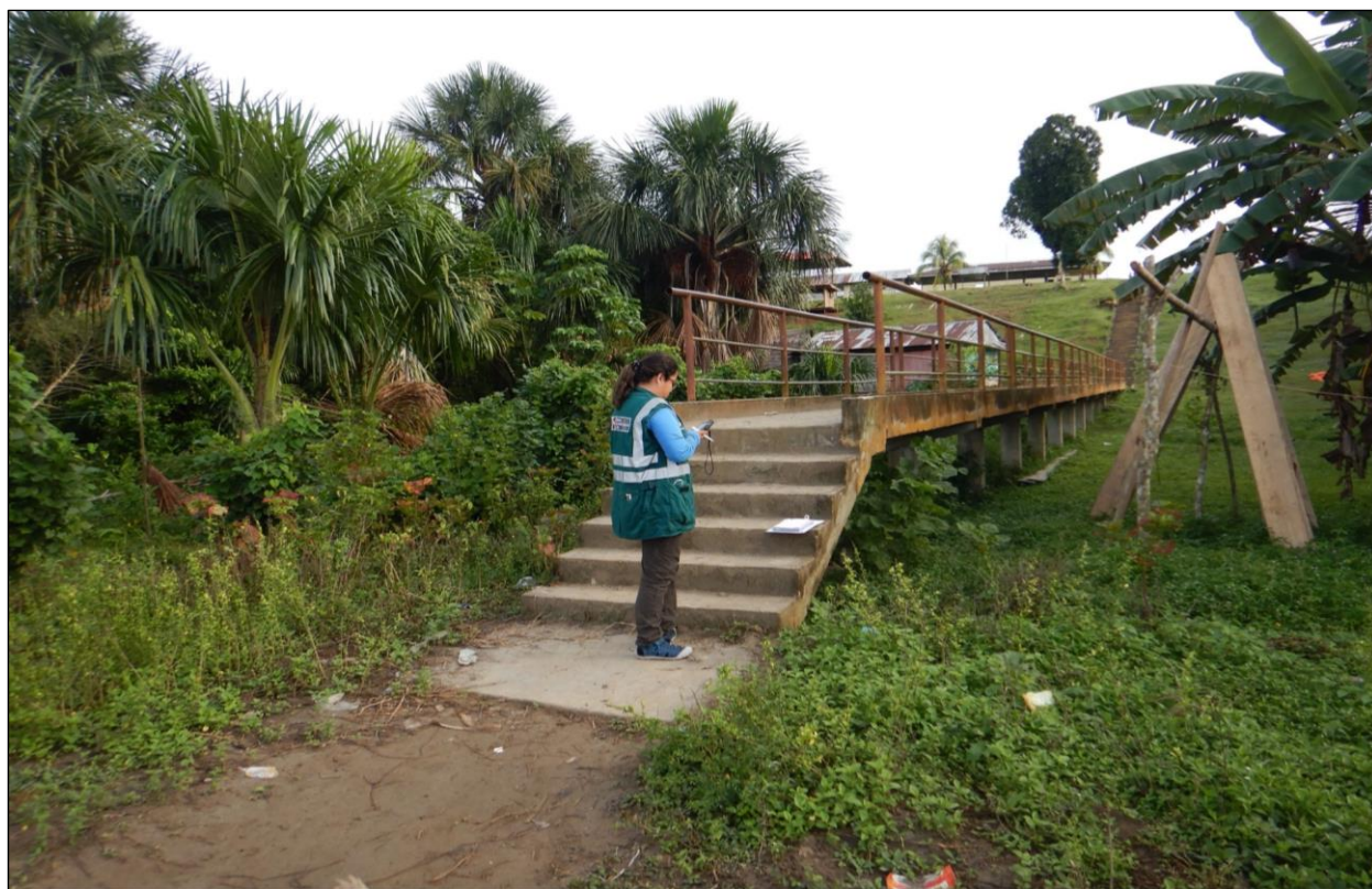
FIGURA N°02: PUENTE/ESCALERA PEATONAL, ÚNICA ESTRUCTURA VIAL, QUE PERMITE EL ACCESO A LA PARTE DE LA COMUNIDAD, SE VE AFECTADA EN PERIODOS DE INUNDACIÓN.
